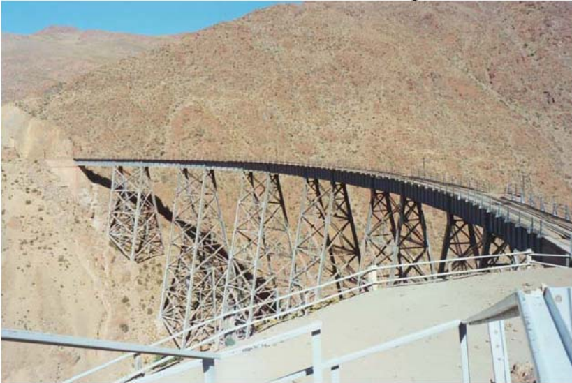
Viadotto della Polvorilla (foto: G.P. Torricelli, 2001)
