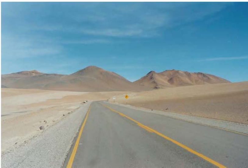
Uno scorcio della nuova strada del Paso de Jama (versante cileno)
